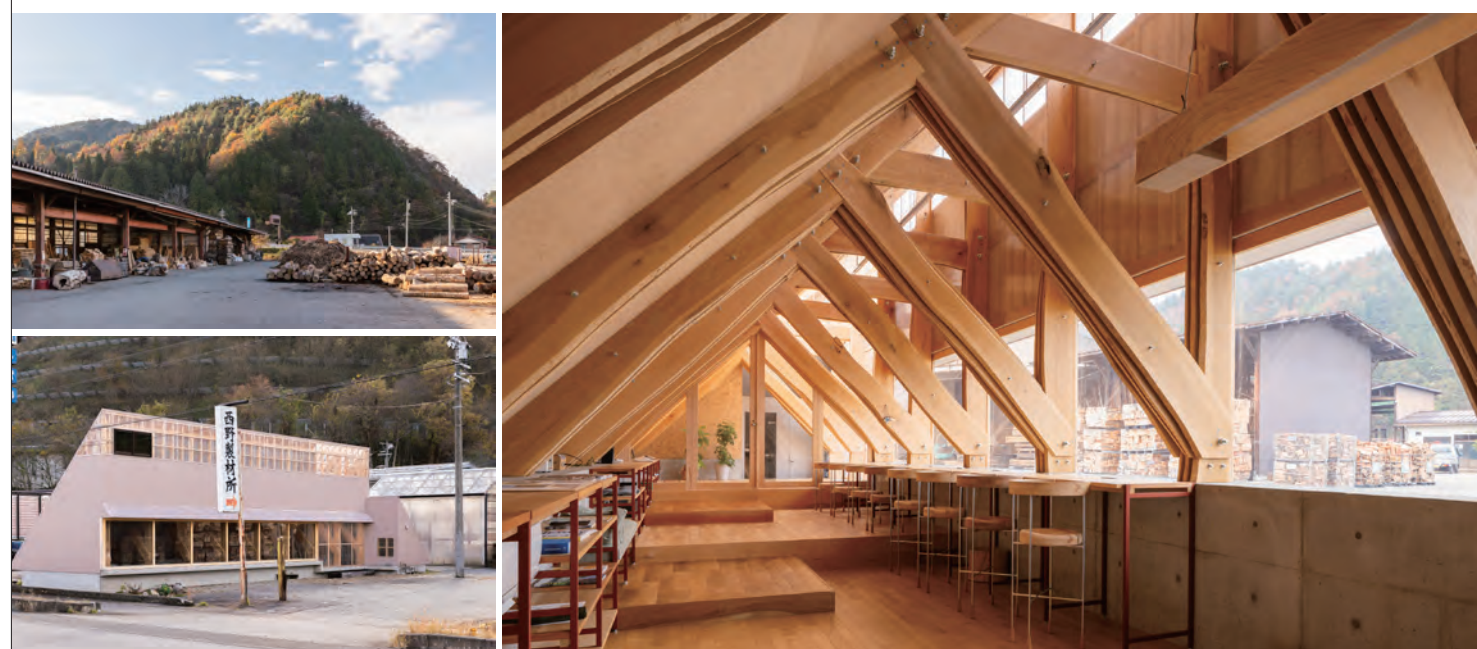
「森の端オフィス」はツバメアーキテクトとチドリスタジオ、ヒダクマが共同設計。国道沿いに建ち、開口部は土場（左上の写真）を向いている。建物の成り立ちを見せるために、構造材はあえて耳を残した。板材は通常、製材後に1年ほど天然乾燥させてから人工乾燥機に入れるが、ここでは製材後の生材のまま人工乾燥させた実験材を使っている。床材や家具・建具だけではなく、断熱材や壁・天井のストランドボードにも広葉樹をフル活用。ストランドボードには樹種による色の違いが現れる。
