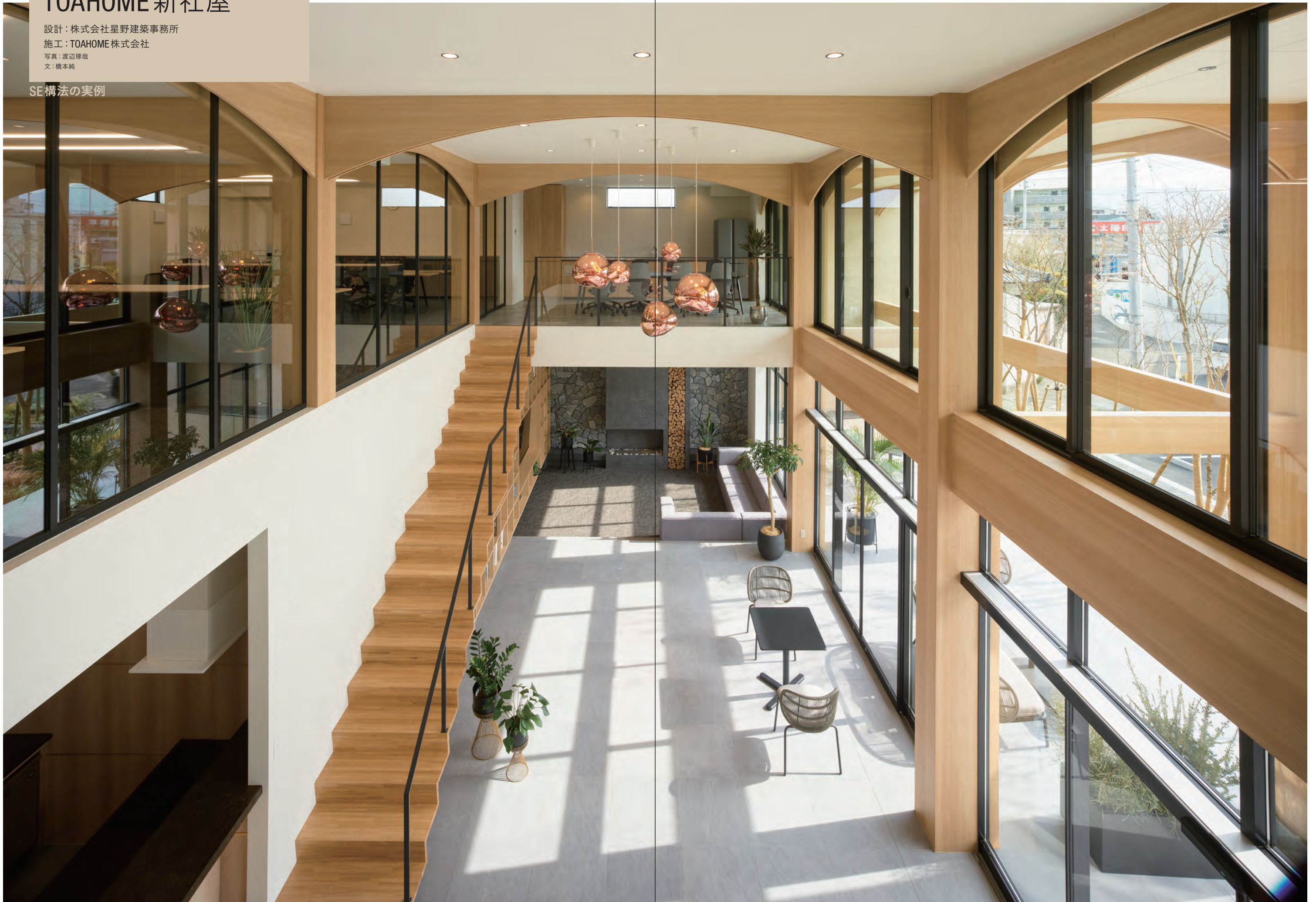
ホールラウンジを見る。幅5,460mm、奥行9,100mm、高さ6,100mmの吹抜け空間。軸組の間に合板を用いたアーチを加えたことで、アーチと軸組の納まり、柱同士の納まりを調整するために、見えがかりの寸法を操作している。
