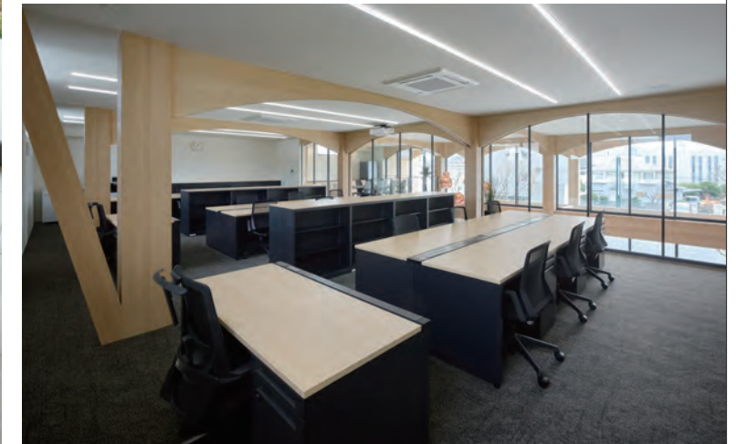
左：キッズコーナーからピロティとホールラウンジ方向を見る。 上：2階フリースペースからホールラウンジ吹抜けを見通す。 下：2階オフィス。左の斜材はデルタ梁で、2階は左の柱芯から910mm左側へオーバーハンクしている。天井高は2,500mm。
