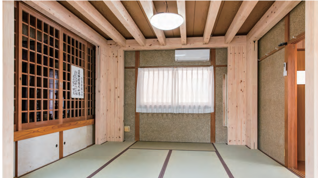
耐力壁で支える構造のシェルターと異なり、開口部が大きくとれるため、設置後も二間続きの和室を今までと同じように襖を開いた形で使い続けることができる。
