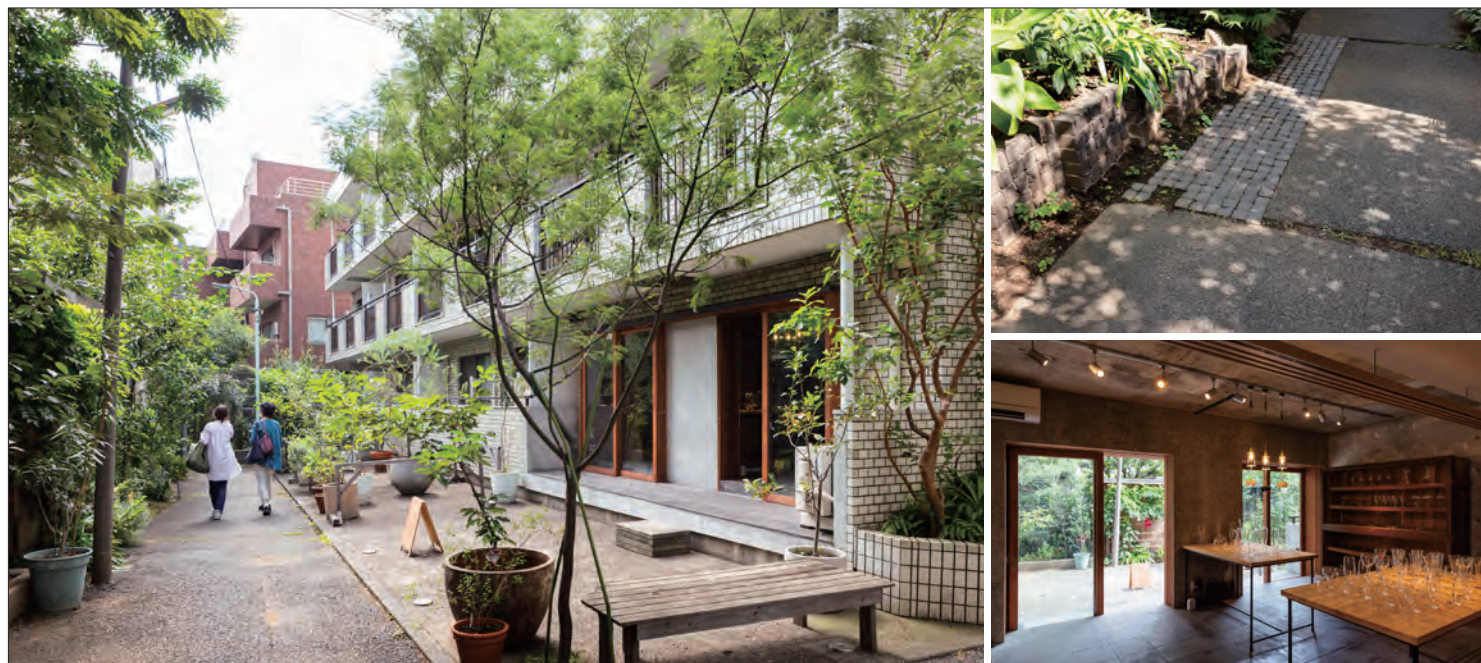
「チャノマ」と「コーポ紫雲」の間の通路。通路はスリット状にアスファルトを削って土を入れ、緑が顔を覗かせるようにしている。チャノマの庭のコーナー部は、煉瓦を半分に切って積み上げ土留めとし、その余った煉瓦も通路に活用して一体感を持たせた。コーポ紫雲の1階角部屋は須藤さんの設計で店舗兼住宅に改修。現在は、作家ものの器を扱うショップが入る。開口部の木製建具が効いている。
