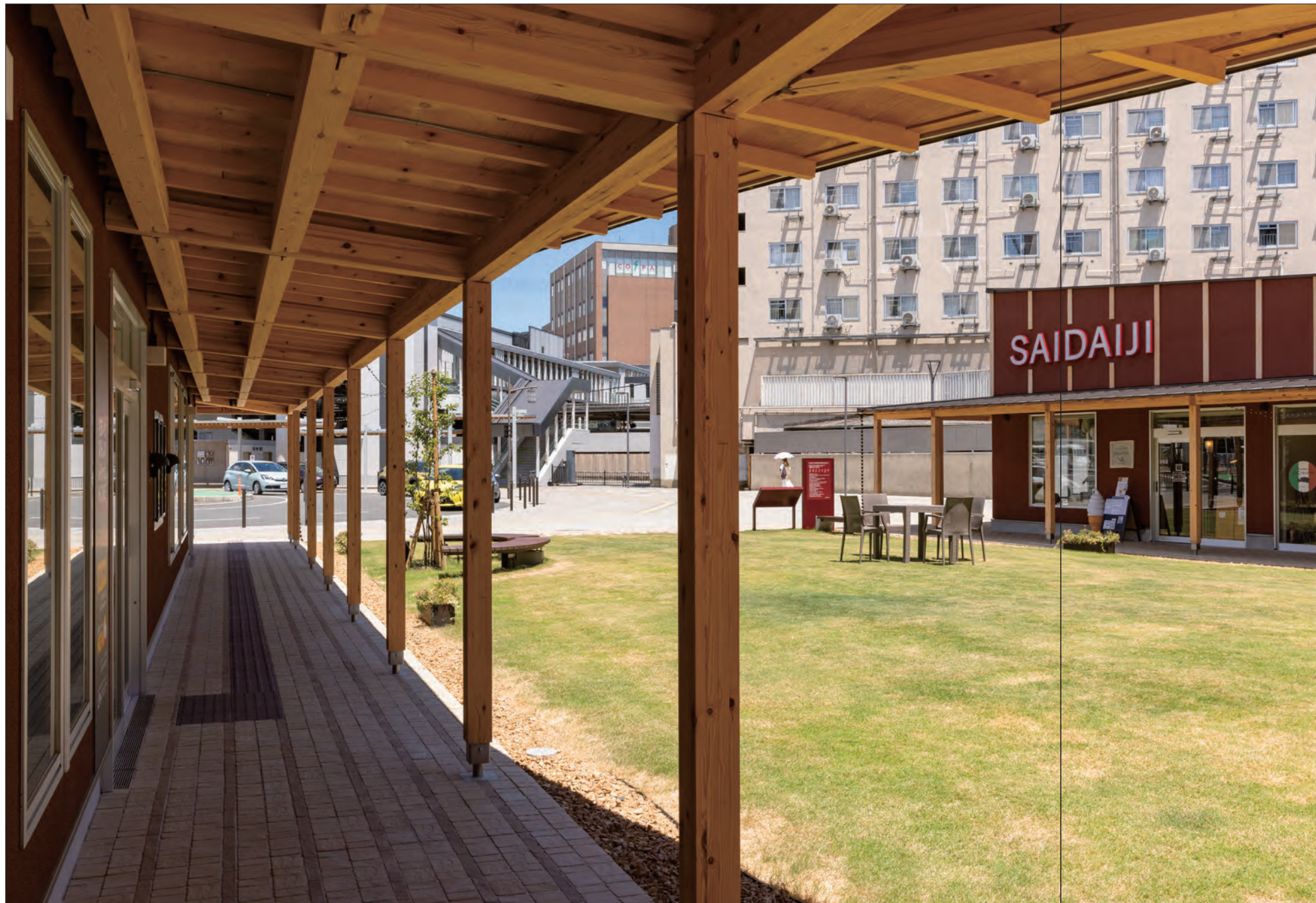
左頁：A棟の下屋空間から芝生広場を見る。下屋の架構は主要構造体ではないこと、庇の梁とA棟の架構の接合部の間にも耐火被覆を施したことで、木部の現し仕上げが認められ、下屋空間の軽やかさを生み出している。
