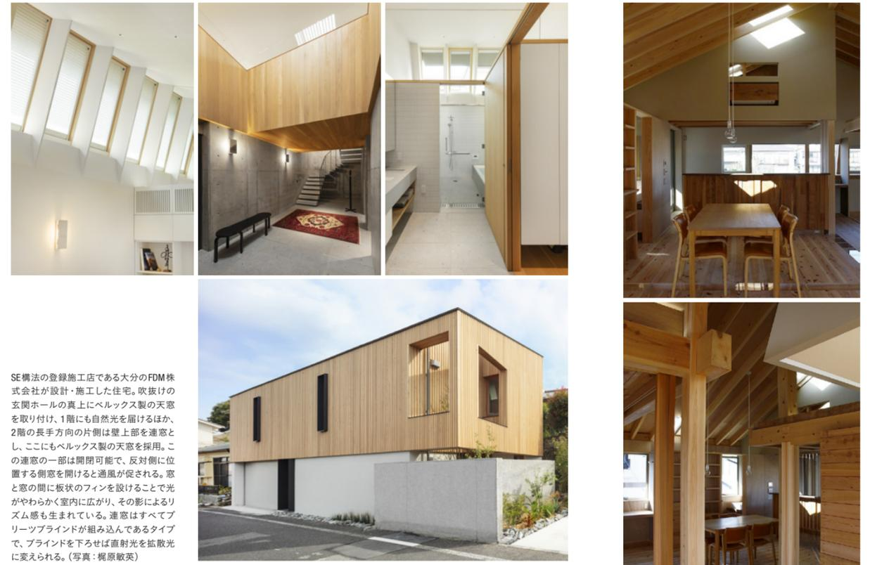
SE構法の登録施工店である大分のFDM株式会社が設計・施工した住宅。吹抜けの玄関ホールの真上にベルックス製の天窓を取り付け、1階にも自然光を届けるほか、2階の長手方向の片側は壁上部を連窓とし、ここにもベルックス製の天窓を採用。この連窓の一部は開閉可能で、反対側に位置する側窓を開けると通風が促される。窓と窓の間に板状のフィンを設置することで光がやわらかく室内に広がり、その影によるリズム感も生まれている。連窓はすべてブリーズブラインドが組み込んだタイプで、ブラインドを下ろせば直射光を拡散光に変えられる。(写真：梶原敏英)
