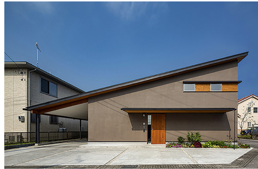
中山大輔建築設計事務所的设计による「宝積寺の家」は、片流れの大屋根のため、タニタハウジングウェアが非住宅向けに開発したガルバリウム製の大型軒とい「HACO/GH12号」を採用。片流れ屋根に大型軒といを付けるケースはしばしばあり、谷田さんは「大きさをわかったうえでデザインを考えないと、軒といだけがぼこりと浮いて見えてしまうことがあります」と注意を促す。(写真：藤本一貴)
