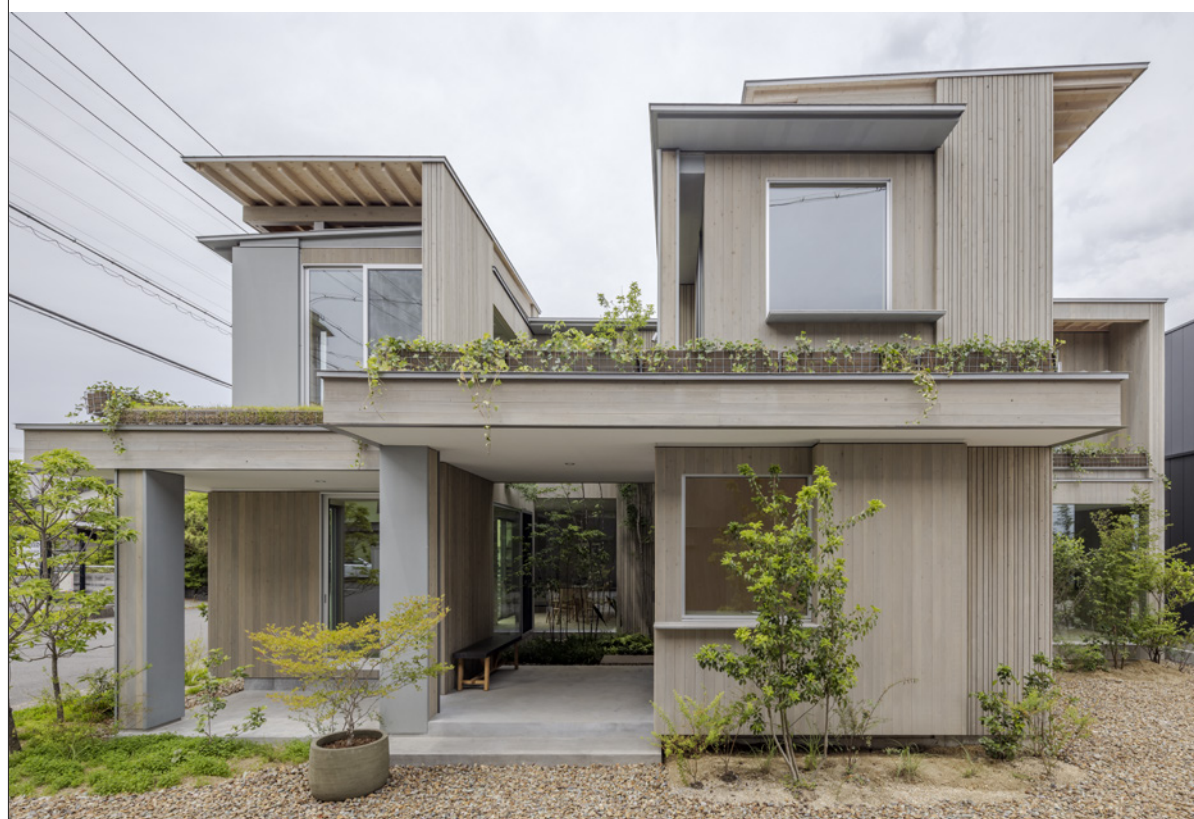
左上：1階ホールからリビング方向を見る。 右上：1階リビングから中庭方向を見る。 左：南側外観全景。1階屋根では一部屋上緑化がなされている。左奥の2階屋根はスケルトンインフィルの考え方を表現したもので、2重の屋根とすることで、温熱環境にも寄与している。
