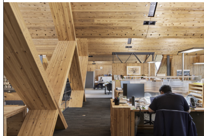
本社事務所はNKSアーキテクト・桃李舎設計業務共同企業体の設計で2019年に竣工。集成材による菱組架構とCLTによる折板屋根を特徴とする。
