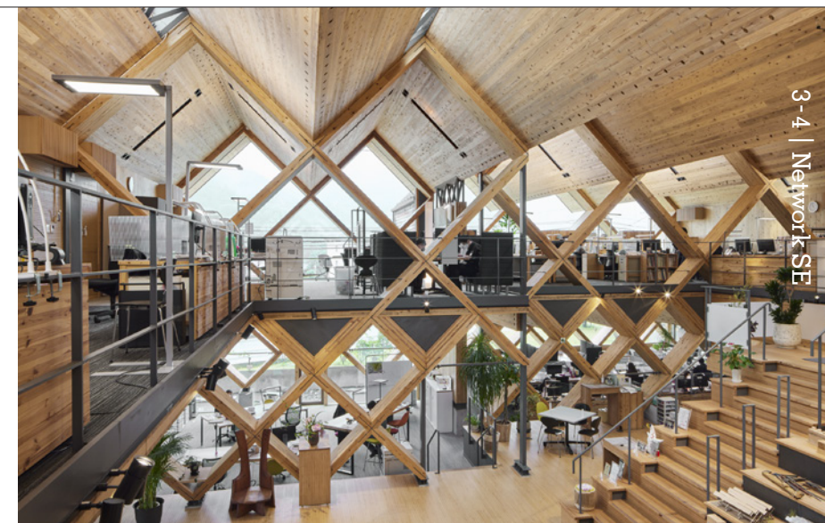
本社事務所はNKSアーキテクト・桃李舎設計業務共同企業体の設計で2019年に竣工。集成材による菱組架構とCLTによる折板屋根を特徴とする。
